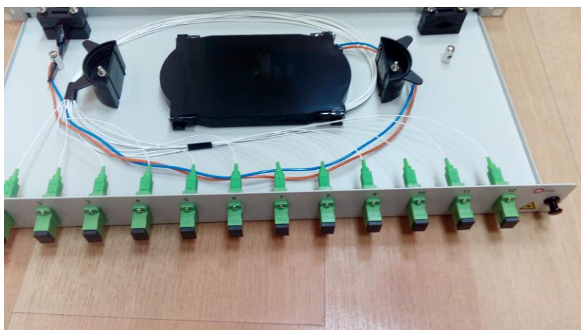
SI.5 Primer montaze Peč panel za 12 o.v.
