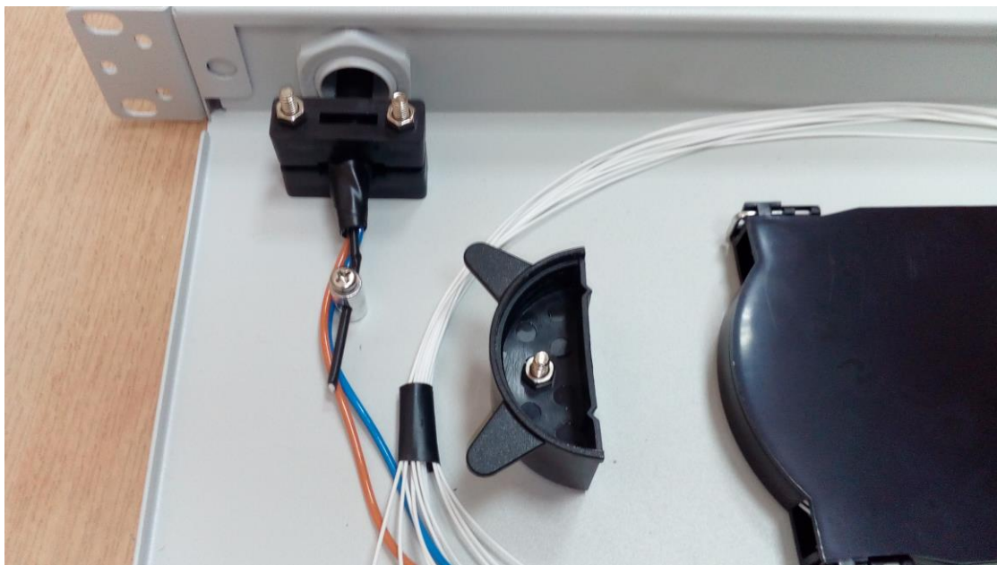
SI.7 Primer fiksiranja uvodnog kabla pomocu rasteretnog elementa
